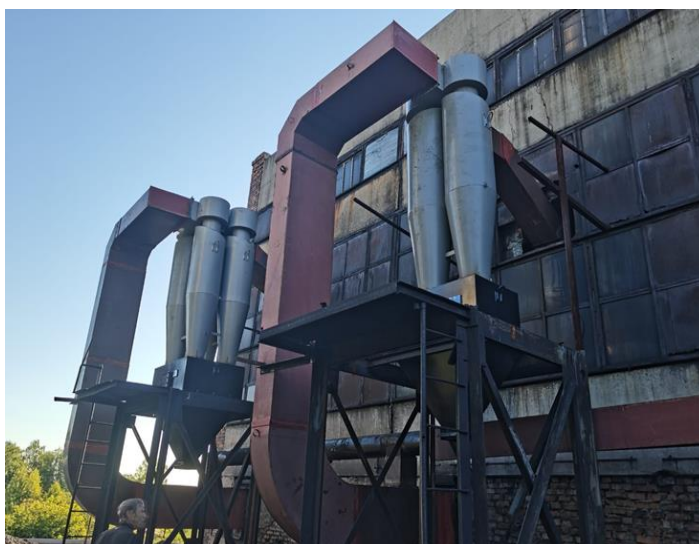
Замена газоходов и циклонов (с. Раздольное)
