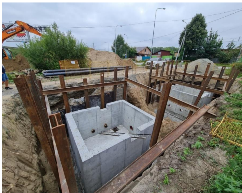
Строительство водовода (с. Барышево)
