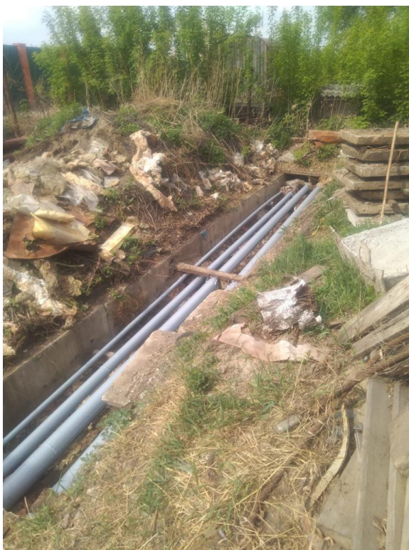
Ремонт теплотрассы (п. Элитный)
