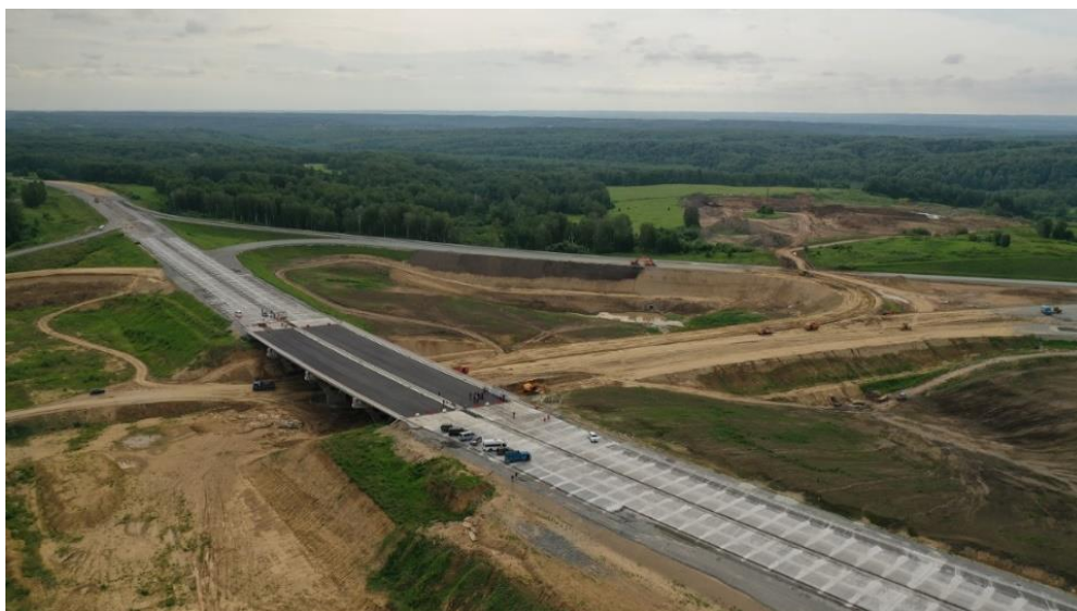
Строительство Восточного обхода (с. Новолуговое)
