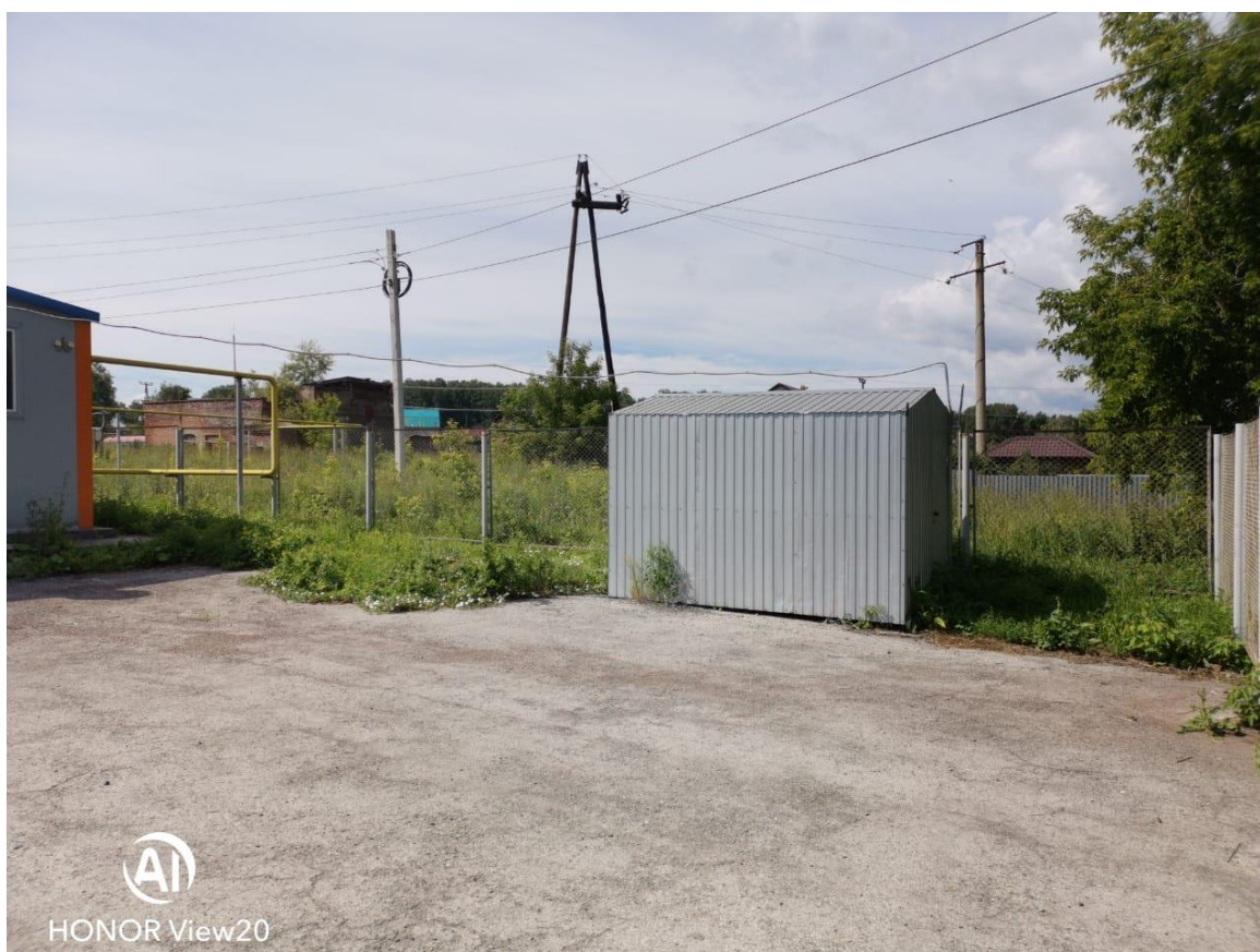
Рисунок 3.16. Здание дизельэлектростанции котельной №4
