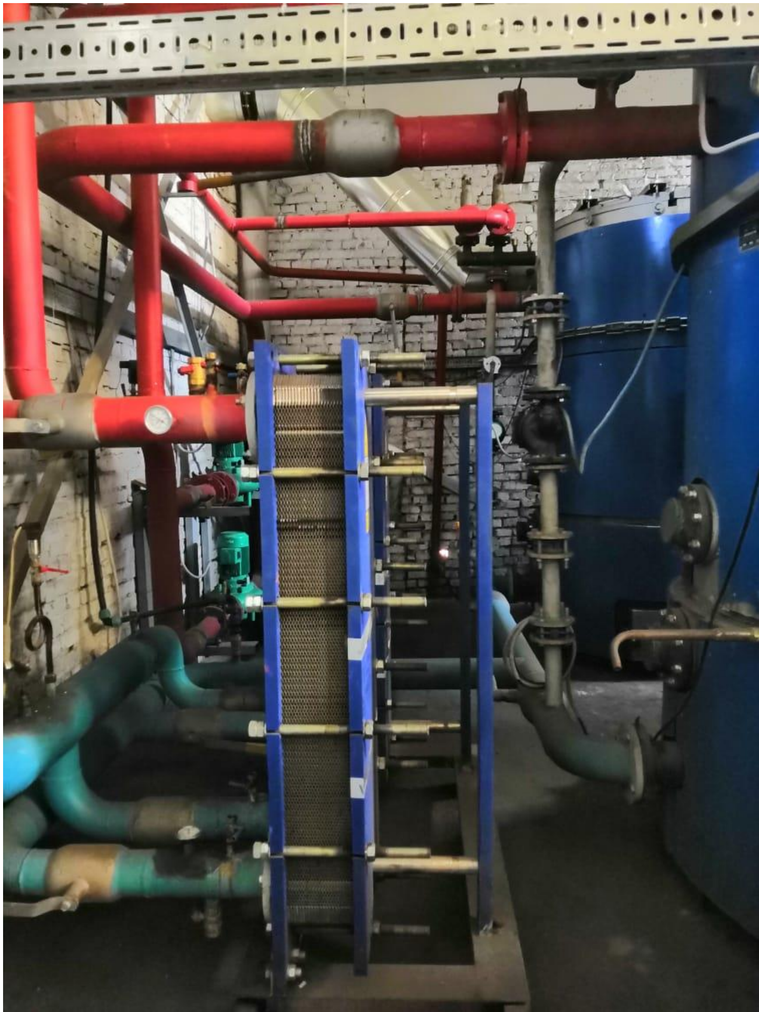
Рисунок 3.2. Теплообменники котельной №1
