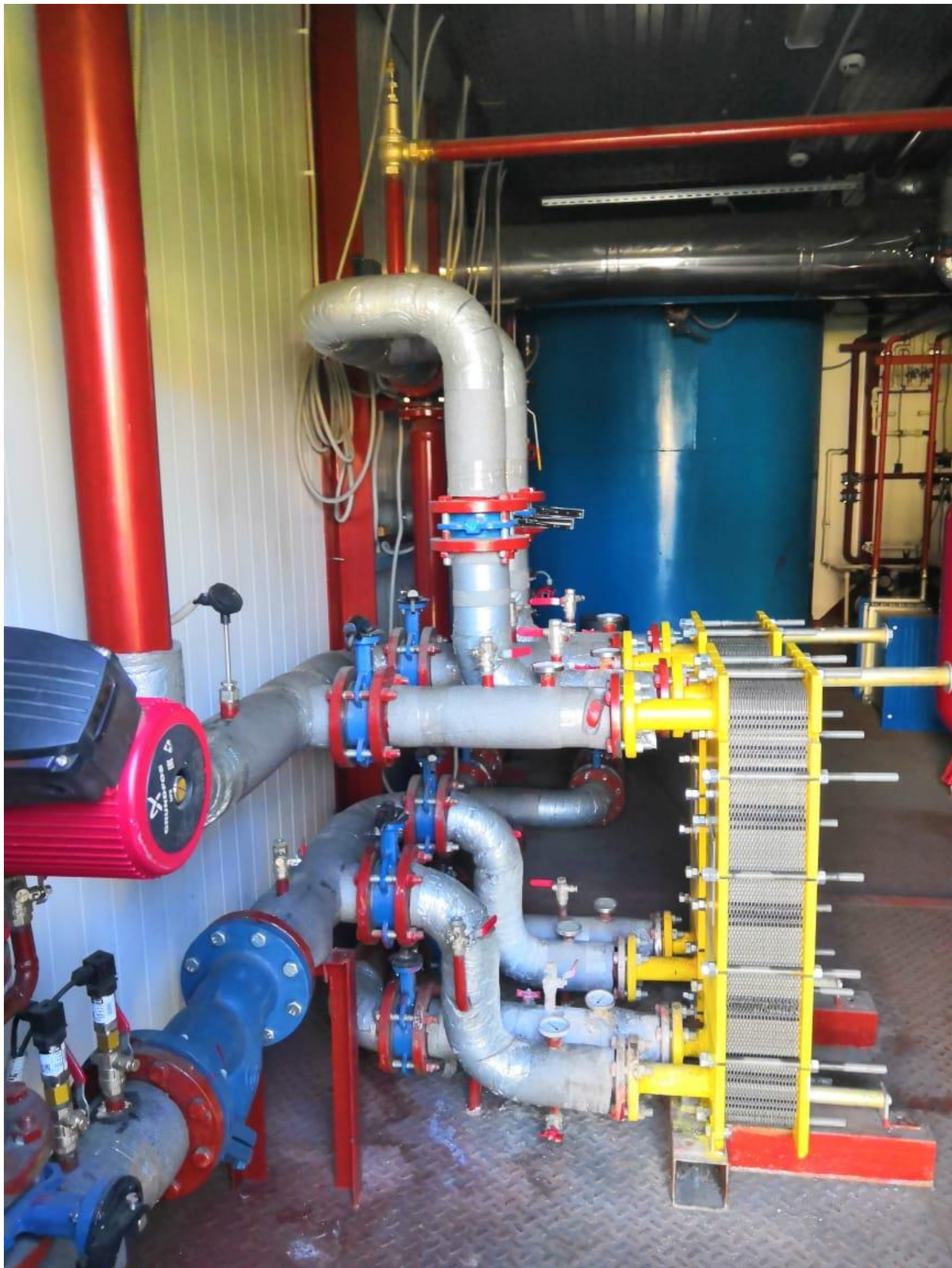
Рисунок 3.25. Теплообменники котельной №7
